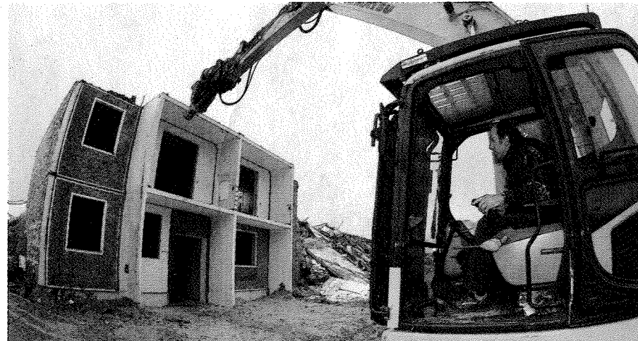
Plattgemacht. Seit Beginn des Stadtumbaus im Jahr 1999 wurden im brandenburgischen Schwedt rund 5400 Wohnungen abgerissen.
