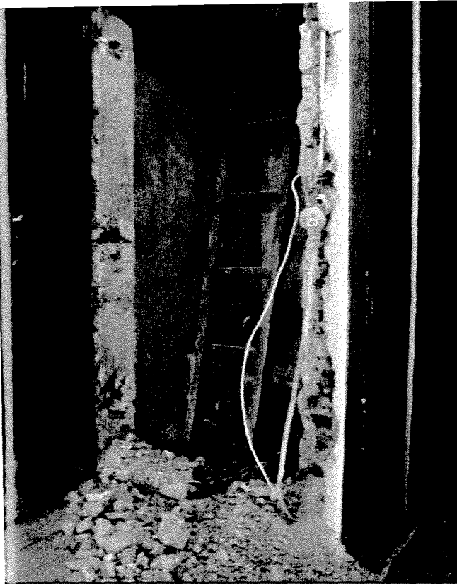
ACHTUNG, STROM! Im Treppenhaus hängen offene Kabel
