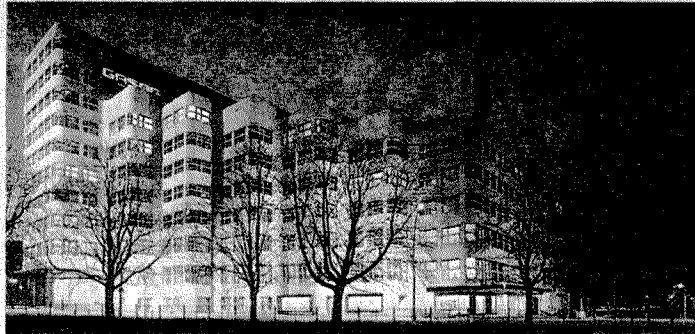
Die Gasag-Zentrale im „Shell-Haus“ am Reichpietschufer Foto: Gasag
