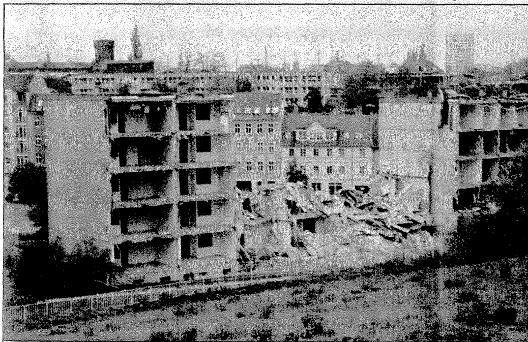
Erst eine Lücke, dann ein leerer Straßenzug: In der Kleinen Müllroser Straße verschwinden sogenannte P2-Wohnungen. Noch 1.000 Wohnungen sollen 2005 in Frankfurt abgerissen werden.
