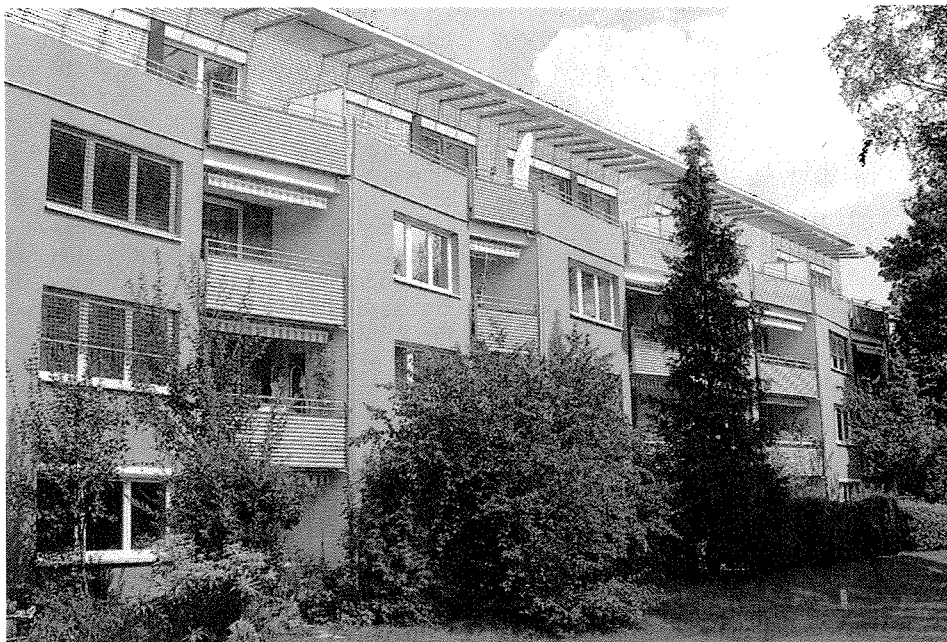
Rosarote Drei-Liter-Häuser: Knapp 1.000 Wohnungen der Anlage Bernadottestraße der wbg Nürnberg wurden umfassend ökologisch saniert. Bild: wbg
