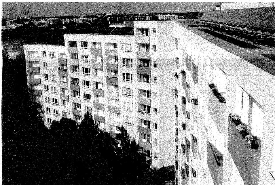
Die Eigentümer des Meller Bogens vertrauen auf die Kraft der Sonne. Vor allem mit ihrer Hilfe sollen knapp 1.500 t Kohlendioxid weniger anfallen. Bild: Charlottenburger Baugenossenschaft
