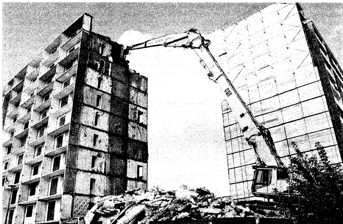
Im brandenburgischen Schwedt werden Plattenbauten abgerissen, um den Markt zu entlasten.
