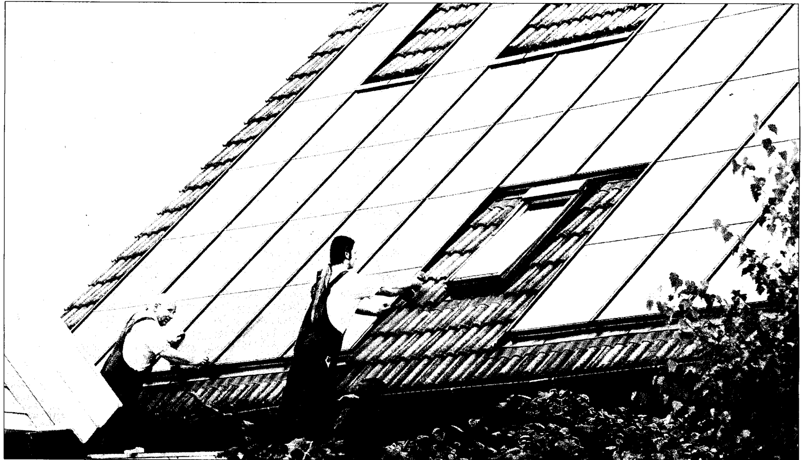
Der Einbau von Solardächern auf Eigenheimen wird jetzt von der Bundesregierung noch stärker gefördert
