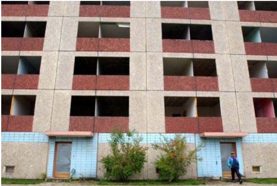
Plattenbau in Schwedt: Der Leerstand zwingt die Wohnungsbaugesellschaften, ganze Blocks abzureißen
