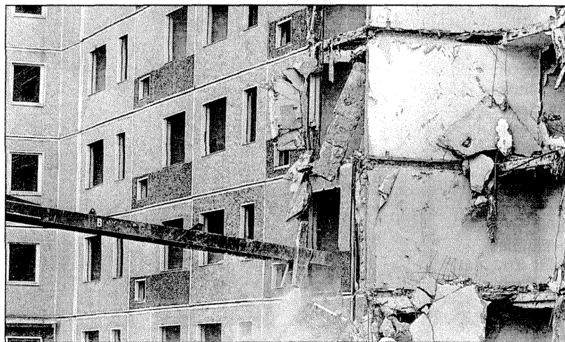
Der Abriss von Wohnungen wie hier in Velten soll weitergehen.
