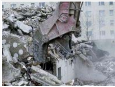
Abriss wird fortgesetzt ©ddp
