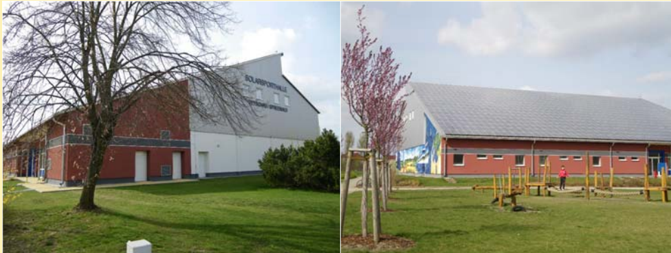
Sanierung der Fassaden und Umfeldgestaltung Solarsporthalle Vetschau
