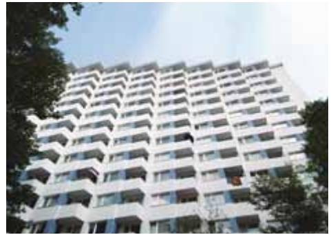
Fassadensanierung „Kurt-Schumacher-Allee 71“ in der Vahr Südost
