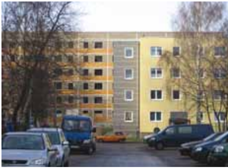
Umgebauter Block der MWG vor Abrisshaus
