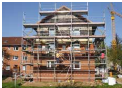
Sanierungsarbeiten in Fruerlund-Süd
