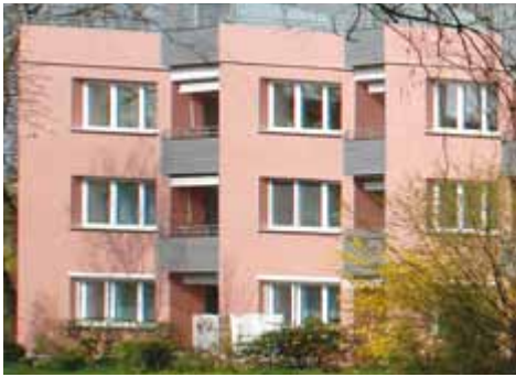
Energetisches Modellobjekt Bernadottestraße 42-48
