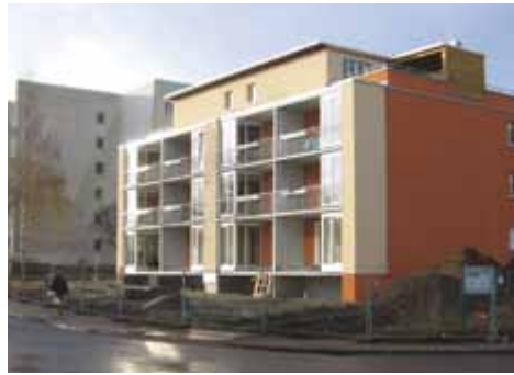
Etagenreduzierung mit neuem Penthouse in Neu-Reform
