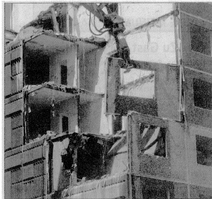
Wie hier in Erfurt werden zurzeit überall in Ostdeutschland leer stehende Plattenbauten abgerissen. Foto: Schutt/dpa
