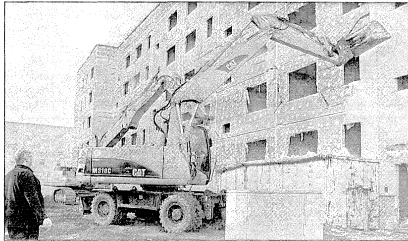
Abriss von Plattenbauten in Wittstock (Ostprignitz-Ruppin). FOTO: MAZ/MADLEN WIRTZ
