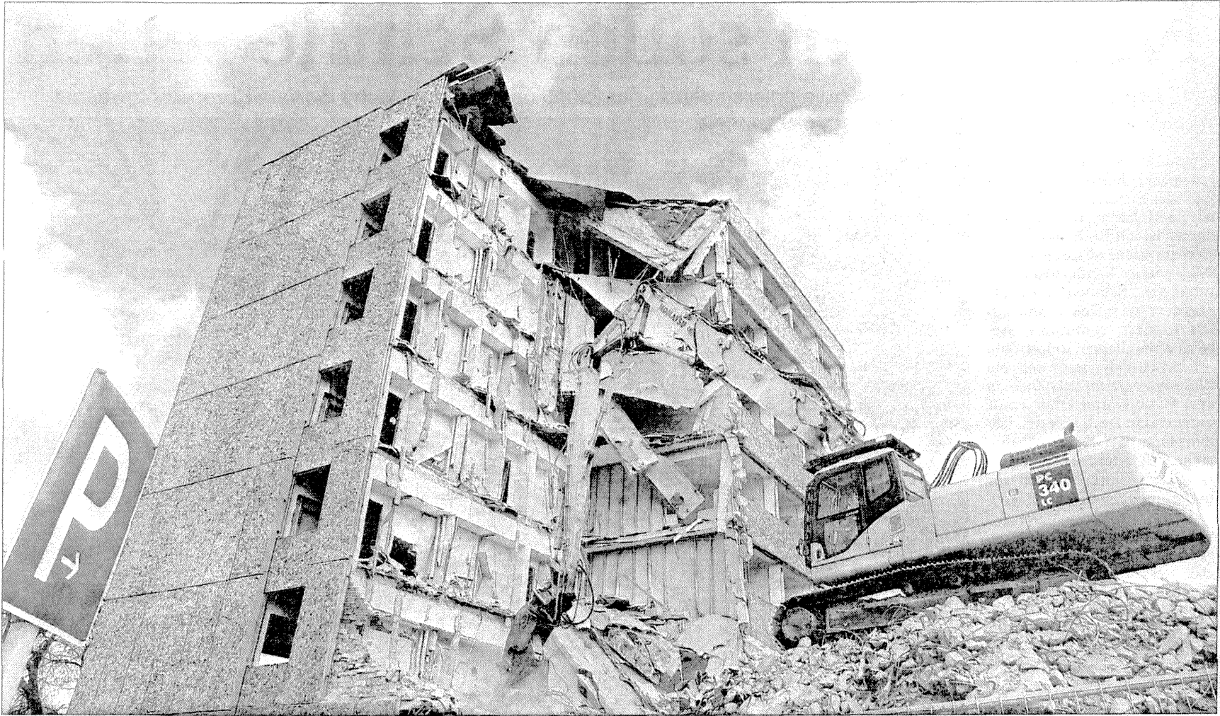
Die Menschen gehen – die Platte weicht: Abriss in Eisenhüttenstadt
