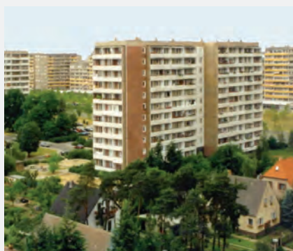
Vor dem Umbau des Doppelhochhauses
