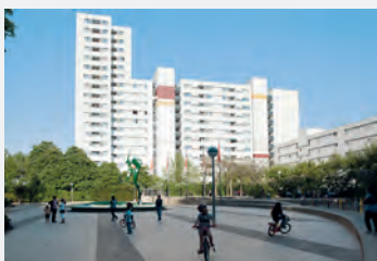
Berlin, Märkisches Viertel: Energetische Ertüchtigung durch Modernisierung
