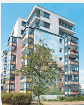
Potsdam: Aufstockung um zwei Geschosse
