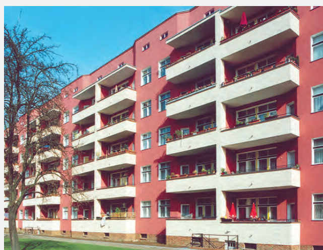
Wohngebäude Gubitzstraße Quelle: WINFRIED BRENNE ARCHITEKTEN, um 1993
