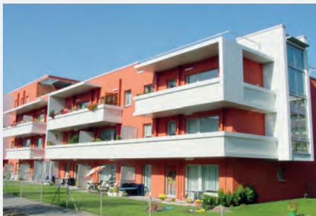
Dresden, Gorbitz( EWG): Umbau und Modernisierung des nachfrageorientierten Gebäudebestandes im Rahmen 'Stadtumbau Ost', Rückbau von sechsgeschossigen Gebäuden auf drei Geschosse, Neugestaltung der Balkone und Terrassen, Anlegen von Mietergärten.
