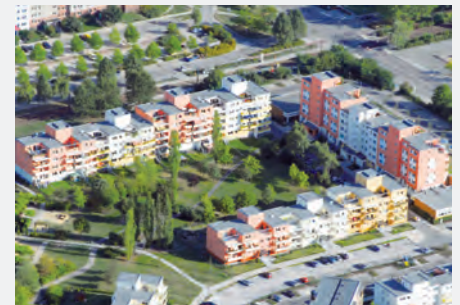
Berlin, Marzahn (degewo AG): 'Ahrensfelder Terrassen' – größtes Stadtumbau-Ost-Projekt, Aufwertung eines ganzen Stadtquartiers, elfgeschossige Plattenbauten wurden zu terrassenförmigen Stadtvillen zurückgebaut.
