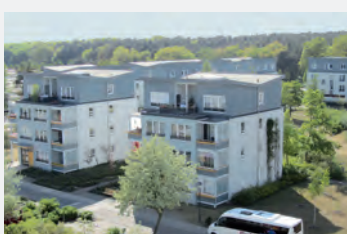
Schwedt: Umbau von Plattenbauzeilen aus den 1970er/80er Jahren zu Stadtvillen
