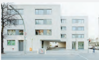
Berlin-Wedding: Siedlungserweiterung der 1920er Jahre durch den Neubau Schillerpark
