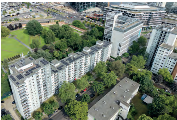
PV-Anlage auf dem Dach der Immobilie Lehrter Strasse, Berlin Beide Fotos © Alva Energie
