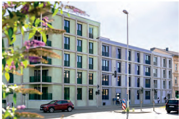
Neubau in der Briesmannstraße © GWC
