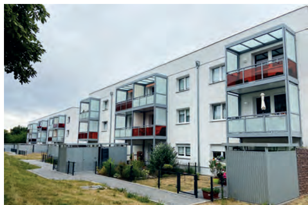
Beispiel Hettstedt: Teilrückbauprojekt im Wohnkomplex IV © Dr. Bernd Hunger
