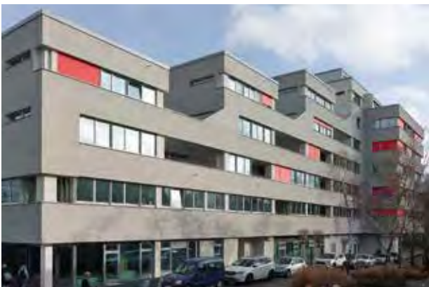
GESOBAU: Umbau von Büroflächen zu Seniorenwohnungen © Stefan Müller
