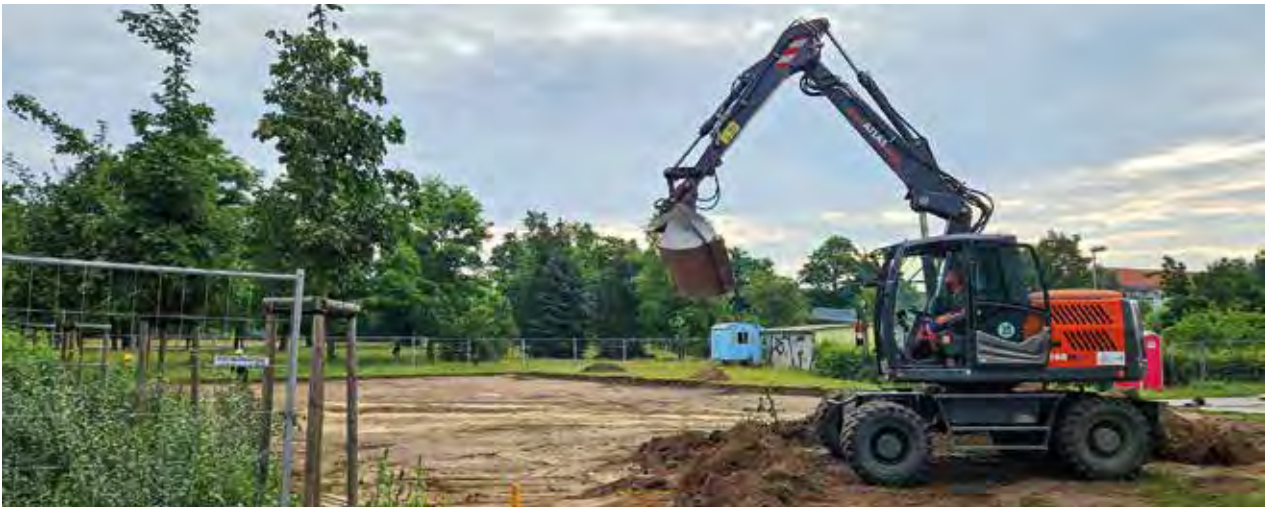
Baustelle für neuen WIS-Parkplatz neben REWE-Markt | Foto © C. Hentschel / WIS Wohnungsbaugesellschaft im Spreewald mbH
