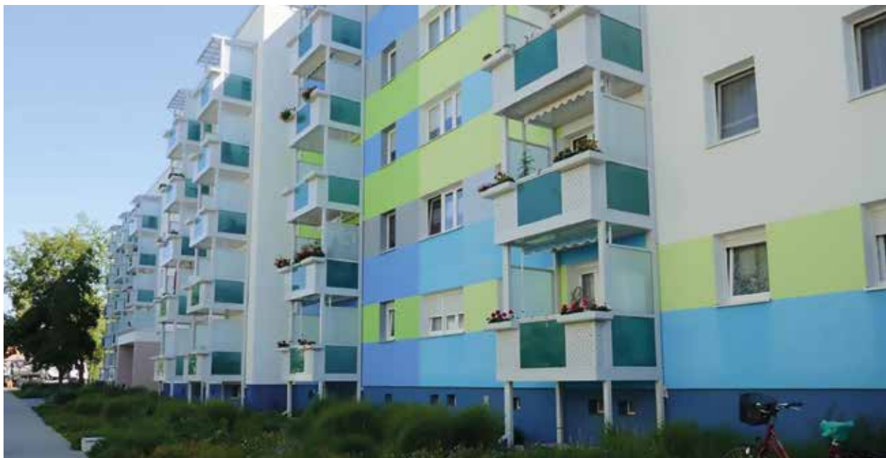
Das ausgezeichnete Objekt: 90 sanierte Wohnungen © KWG
