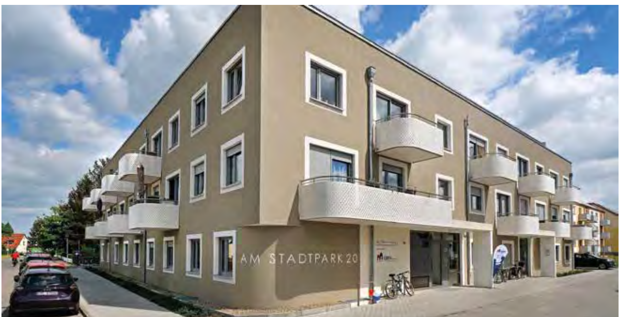
Das ausgezeichnete Objekt: Straßenfront © Büro13
