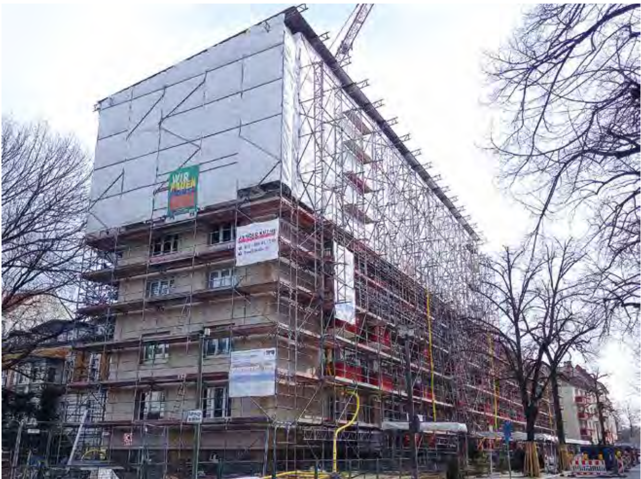
Dachgeschossaufstockung in der Hadlichstraße in Pankow ©: EWG
