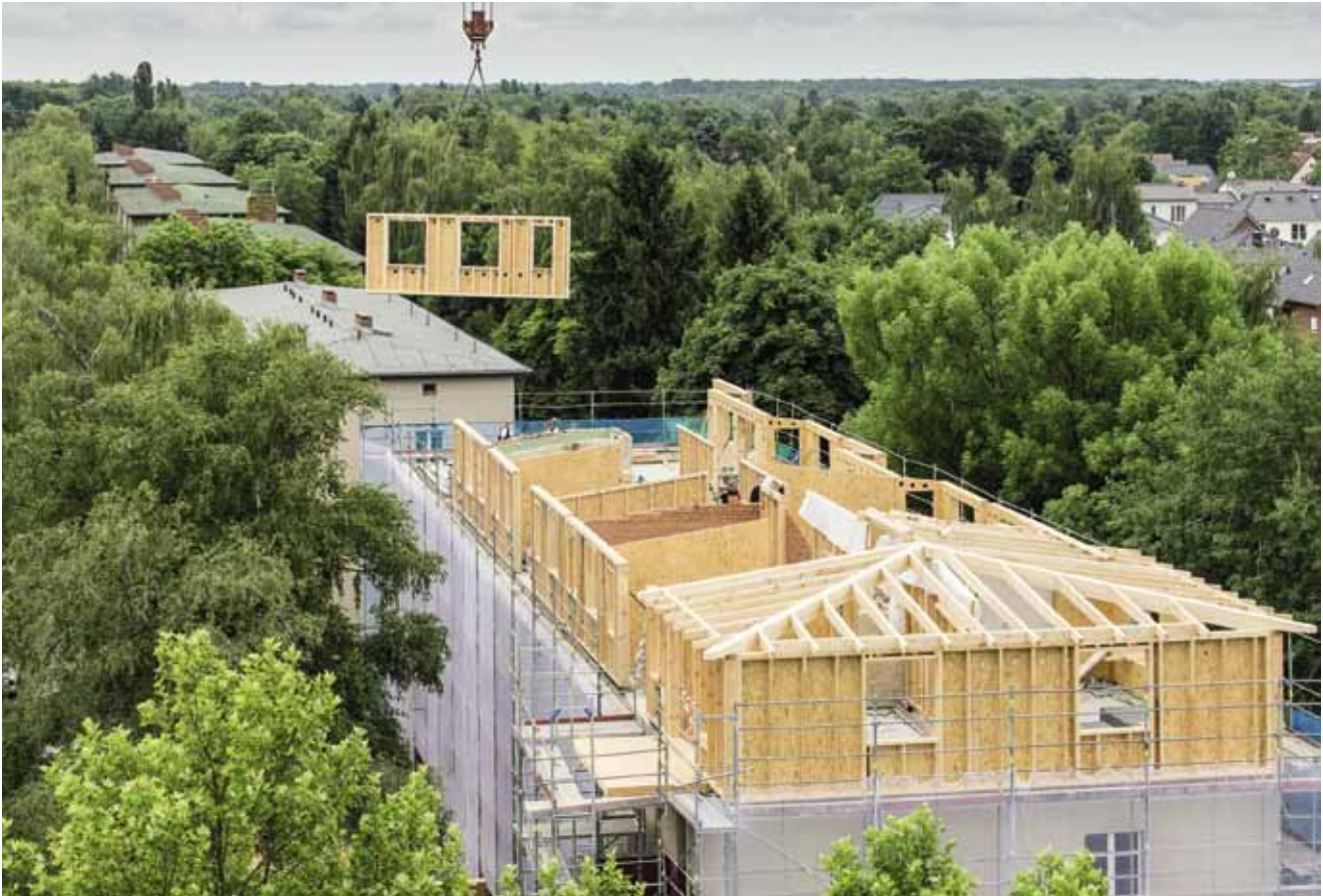
A41 Dachgeschossaufstockung in Holzbauweise zur Wohnraumerweiterung.
