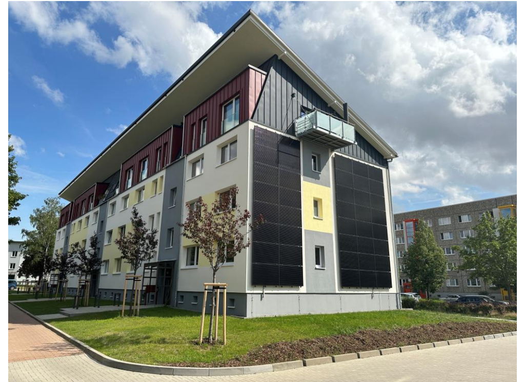
neue Ansicht (Nordosten)
