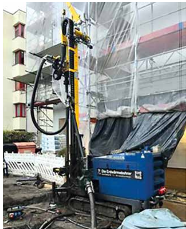
Erdwärmebohrung © BA Reinickendorf
