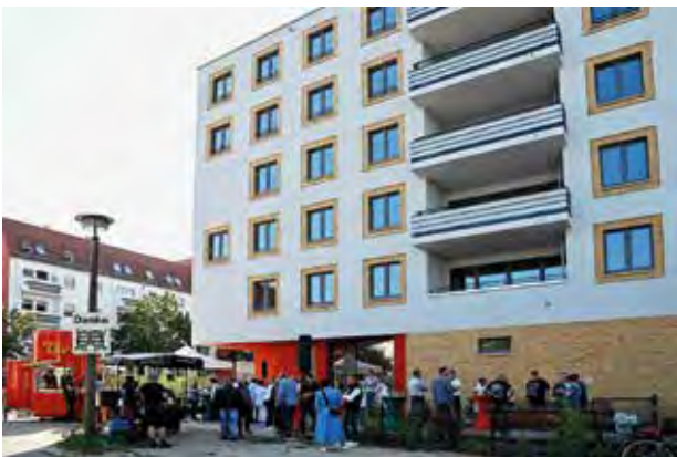
Der Neubau in der Rudower Straße ist das neue Zuhause für viele Genossenschaftsfamilien und zwölf Bewohner einer Pflege-Wohngemeinschaft.
