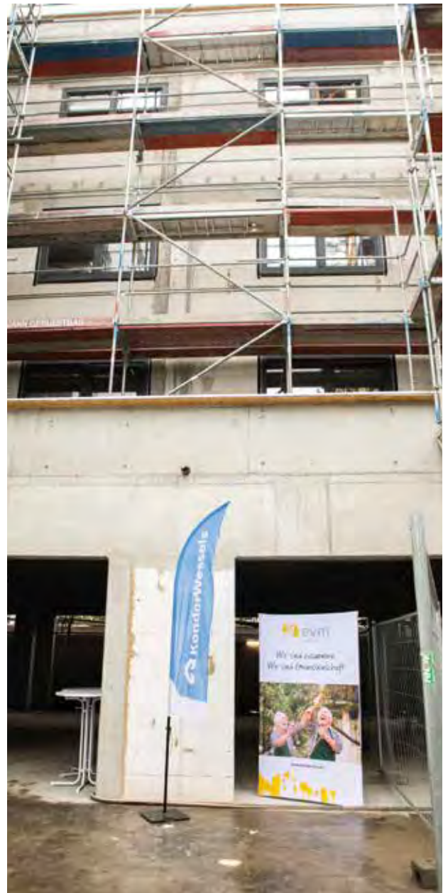
Rückseite Rohbau Soziales Zentrum Mariendorfer Damm (Ansicht Hoefweg) | Fotos © EVM Berlin eG
