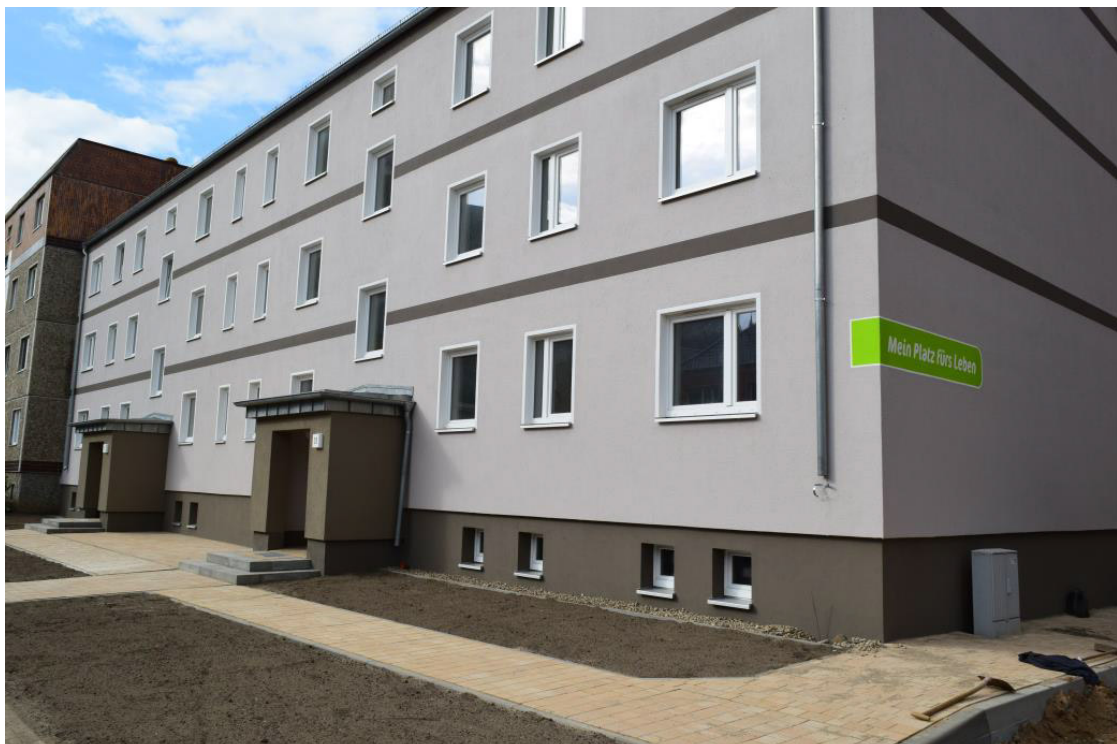
Klosterstraße 20-22 nach der Modernisierung 2016
