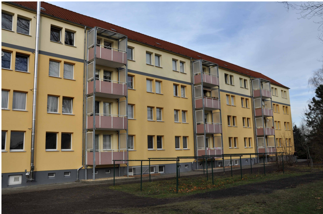
Foto: Neue Fassade im Malerviertel (Foto: KWG)
