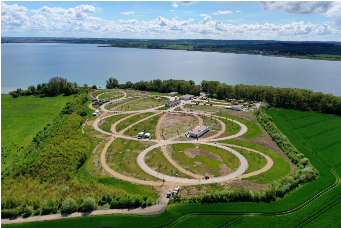
Blick von oben auf den Campingplatz Sonnenkap. (Foto: Wohnbau)
