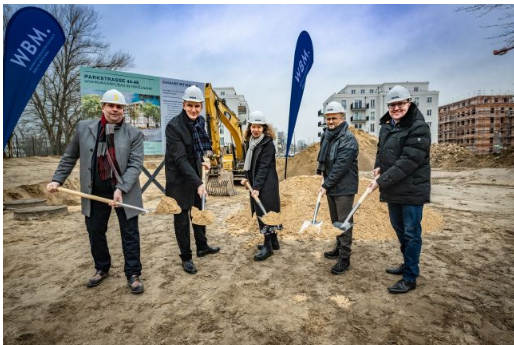
Baustart in Spandau, Copyright: Claudius Pflug
