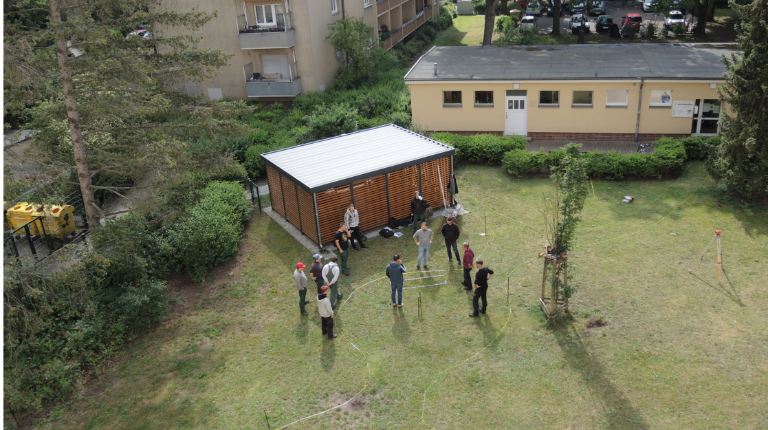
Baubesprechung zum Start der Arbeiten (c) Märkische Scholle
