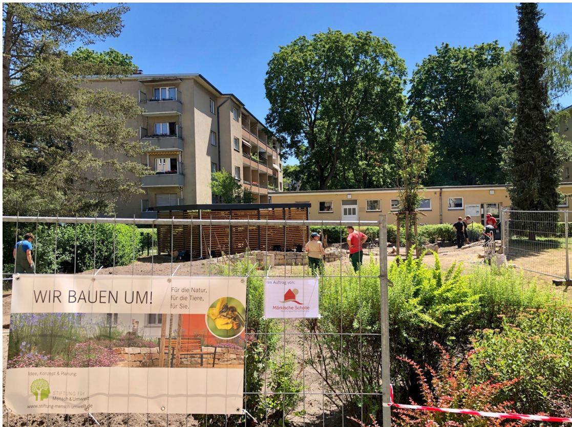
Baustellenimpression (c) Märkische Scholle
